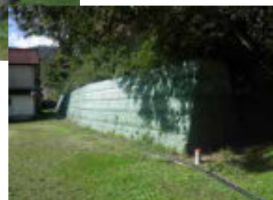
安全対策工事後
